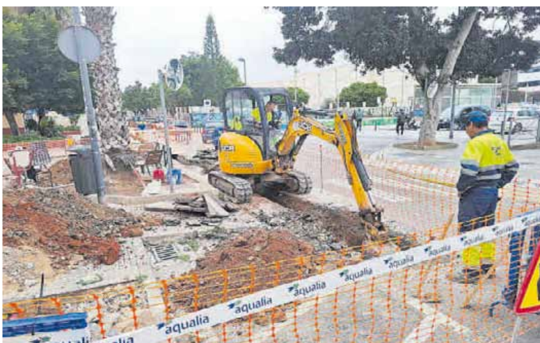
Obras en la calle de Vicent Serra i Orvay, en la tarde de ayer, para tender las canalizaciones.
