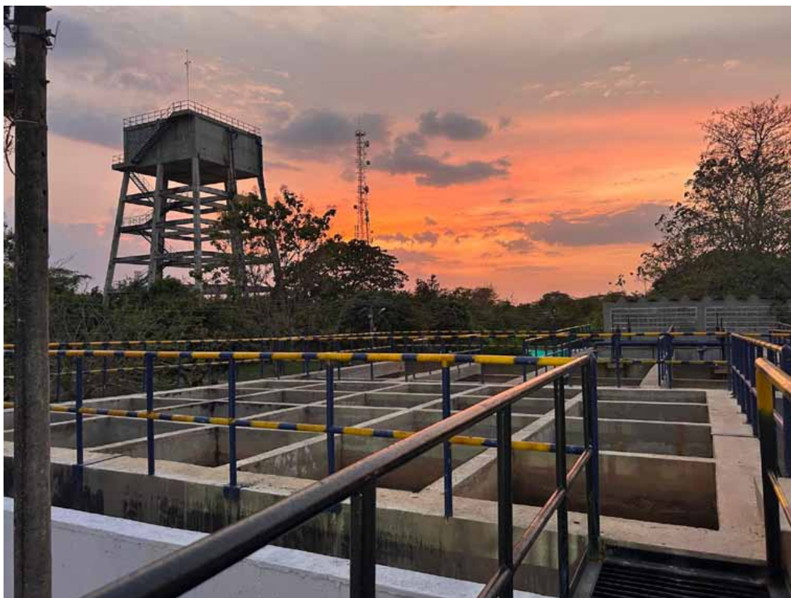
Aqualia en el Magdalena reanudó la operación en la planta de Tratamiento de agua potable de Fundación, tras haber controlado un vertimiento ocurrido aguas arriba de la bocatoma de la planta.
